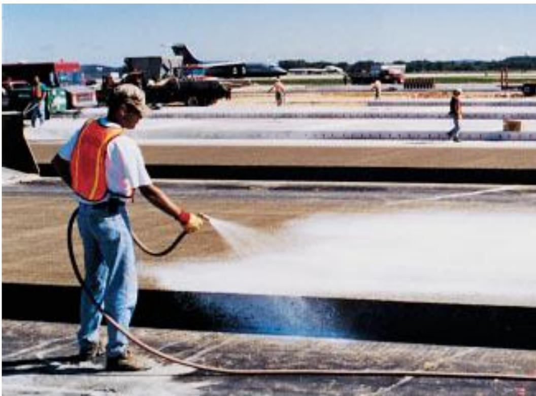
*Figura 2.* Los compuestos líquidos formadores de películas.
