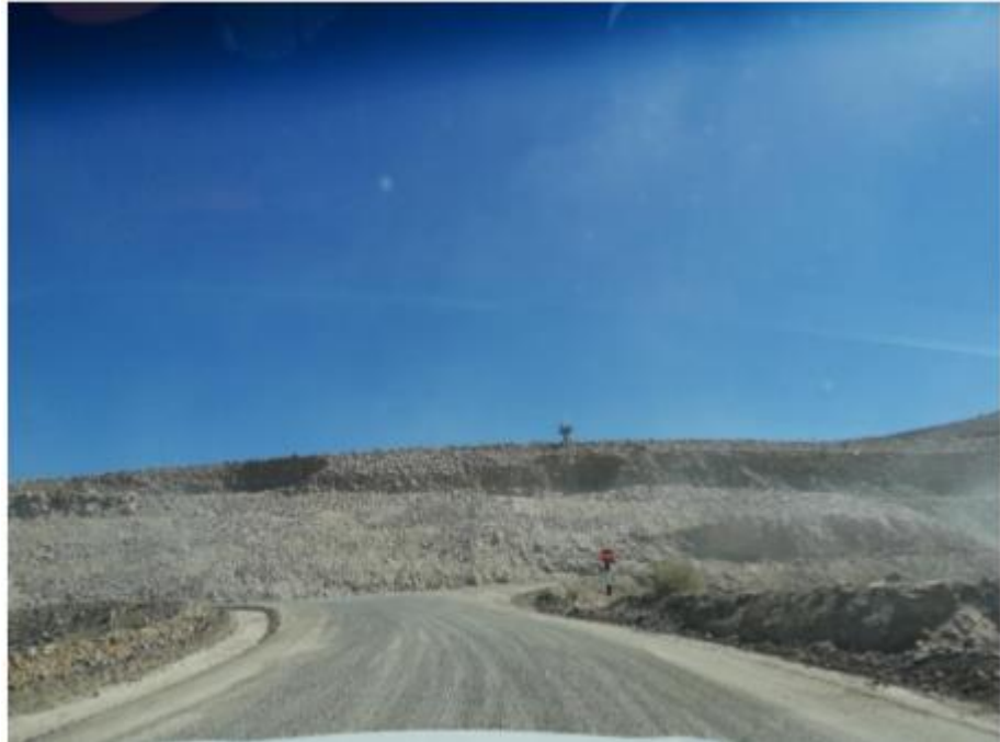
Figura 7 Vista General del Tramo I Km 21+500 A Km 31+150
