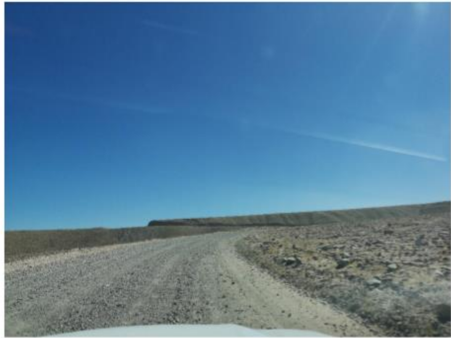
Figura 8 Vista General del Tramo II KM 31+150 A KM 36+60
