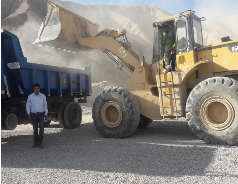
Figura 60. Carguío al camión con material grava 1/2"
