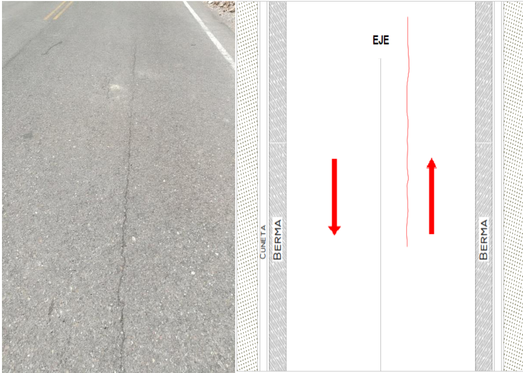
Figura 1. Fisura longitudinal
