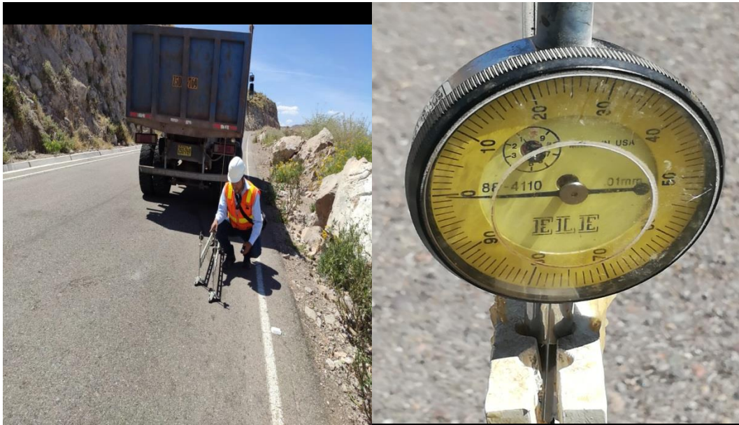
Figura 16. Colocación de la Viga Benkelman. Posición inicial y final
