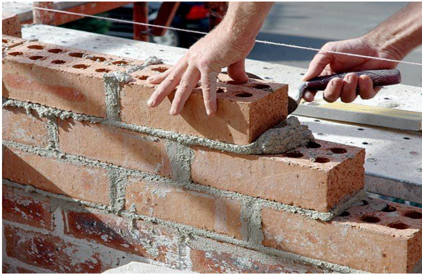
Figura 1. Manipulación de la unidad de albañilería con una mano Fuente: Caliza Cemento Inca S.A., s.f.
