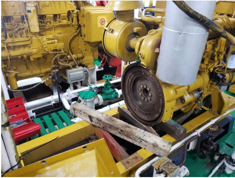
Figura 33. Desacople de la parte mecánica y eléctrica del generador Caterpillar Modelo 3304
