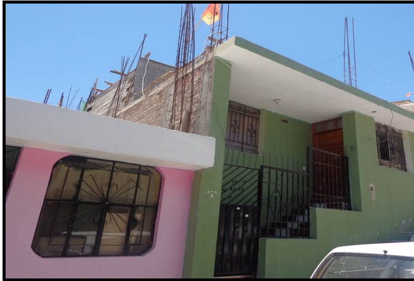
FOTO 6.4: Techos de viviendas a desnivel, sin juntas (vivienda 04)
