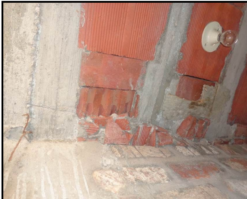
FOTO 4.6: Techo con losa aligerada (vivienda 15)
