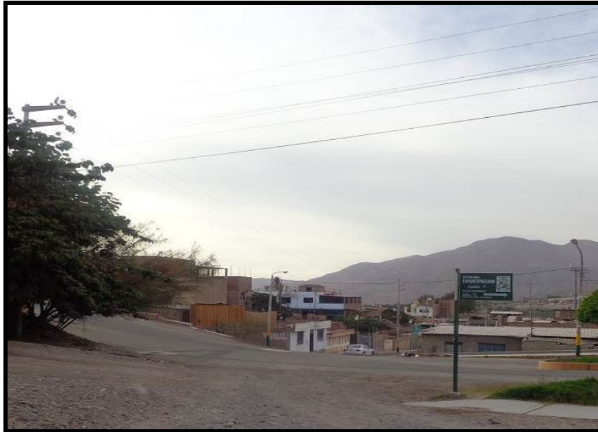
FOTO 6.2: Vivienda en Cauce de Quebrada seca (vivienda 10)
