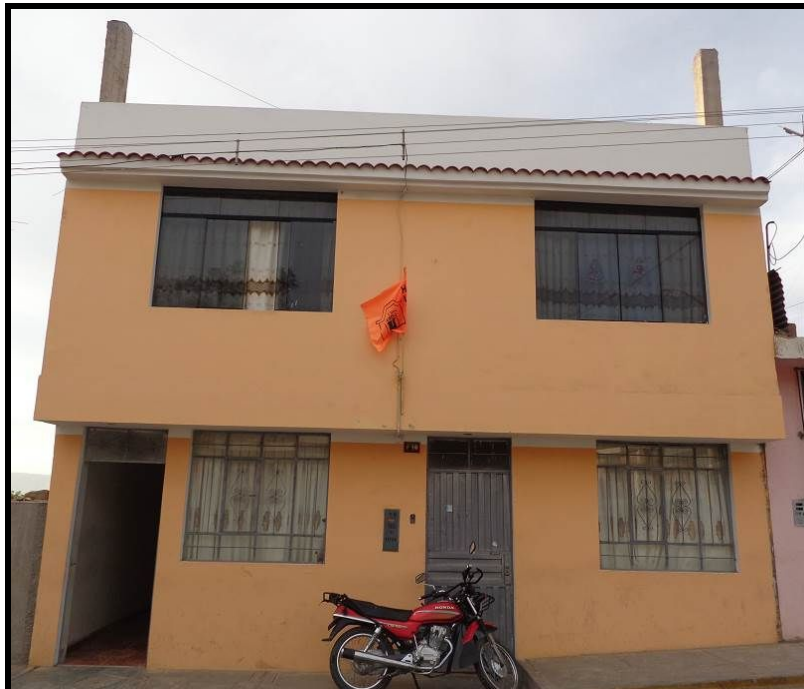
FOTO 4.2: Vivienda de dos pisos (vivienda 18)
