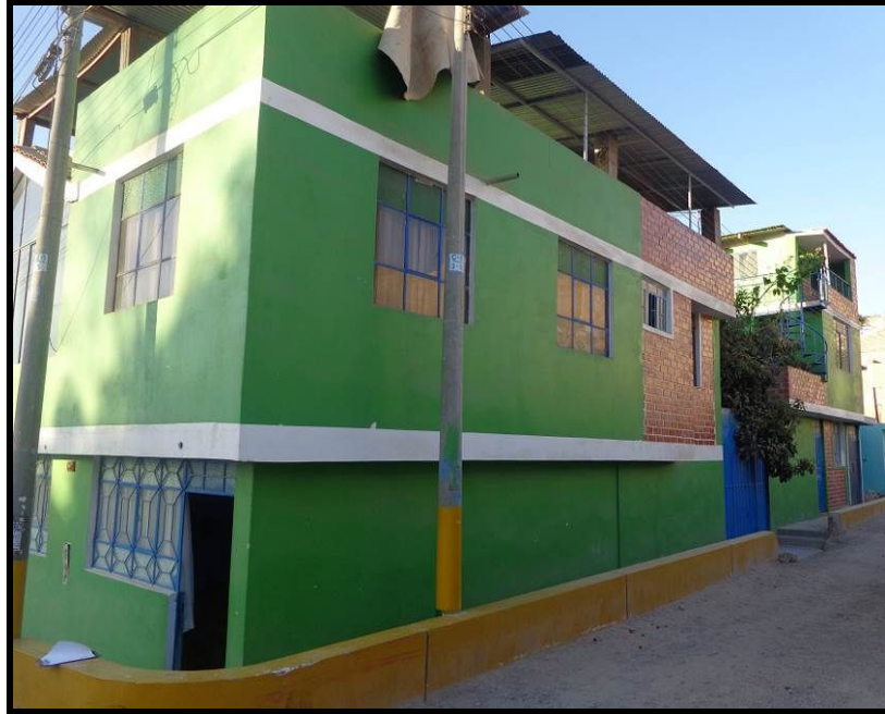
FOTO 4.3: Vivienda de tres pisos (vivienda 03)
