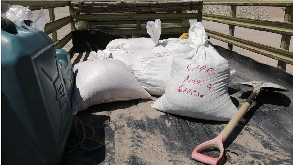
Figura 27. CMR Almacenamiento y transporte del agregado
