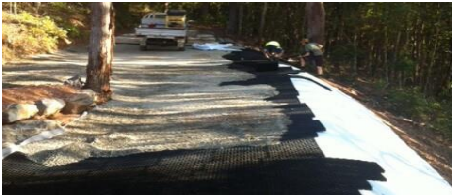
Figura 7. Ejecución de la Obra
