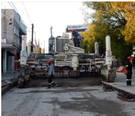
Figura 15. Extendido del Concreto
