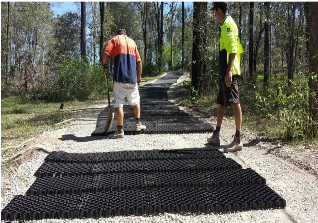
Figura 5. Proceso de colocación de Diamond Grid
