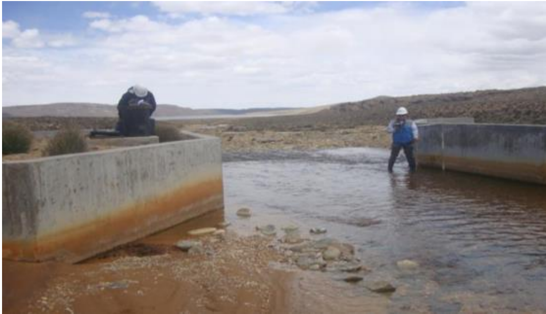
Figura 5. Estructuras de control de afluente – muros de encauzamiento
