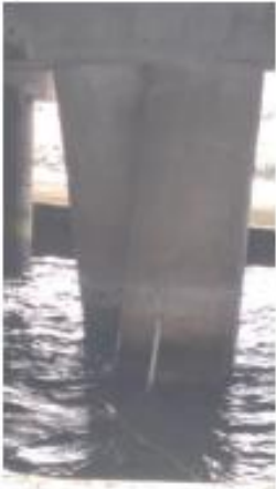
e. TOMA DE MEDIDAS AL PILOTE N° 3.5A
