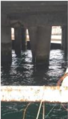
f. TOMA DE MEDIDAS AL PILOTE N° 3.5B
