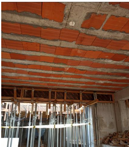
losa aligerada semisótano bloque G
