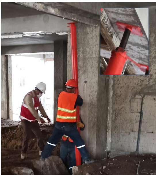
Colocación de puntales de acero C-40
