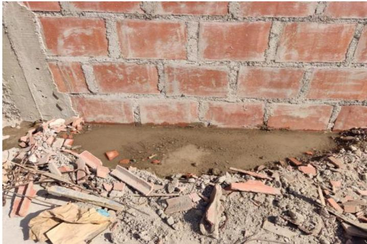
Para mortero con aditivo impermeabilizante Sika 1, en una dosificación de 1.8 lts. por bolsa de cemento; se puede apreciar que el aditivo bloquea los vacíos capilares con el gel incorporado que contiene, convirtiendo este mortero impermeable al 100% en posición horizontal y vertical, por ende, la humedad no asciende. fig. 32
