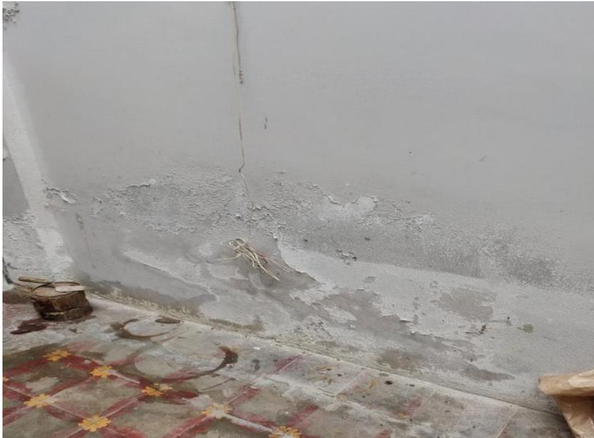
*Nota : Radier saturado de humedad y consecuente humedad en los muros.*
