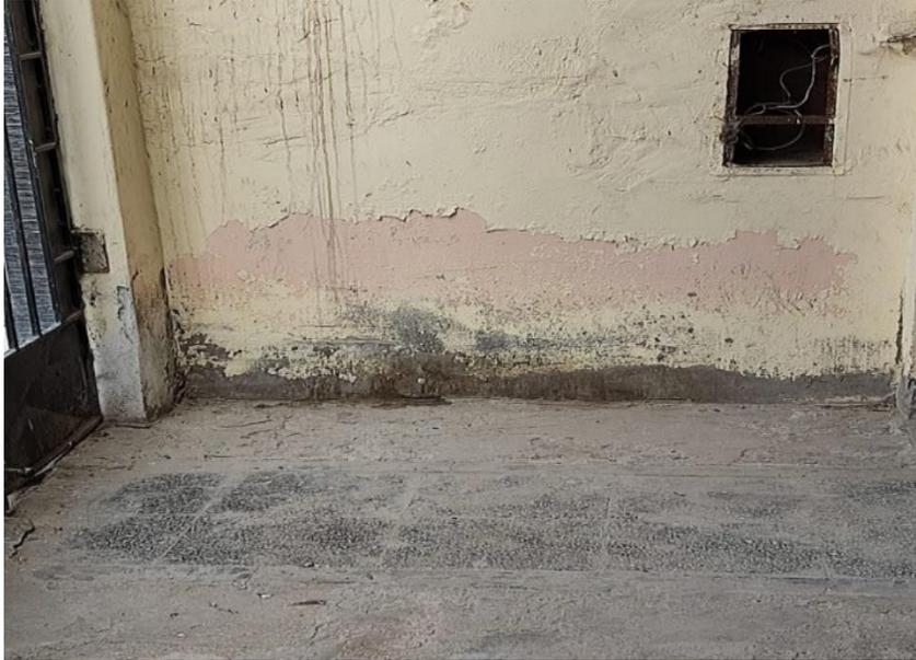
*Nota : Criptoflorescencias en radier ( alta porosidad) humedad proveniente de suelos, deficiencia constructiva (considerable daño a la estructura).*
