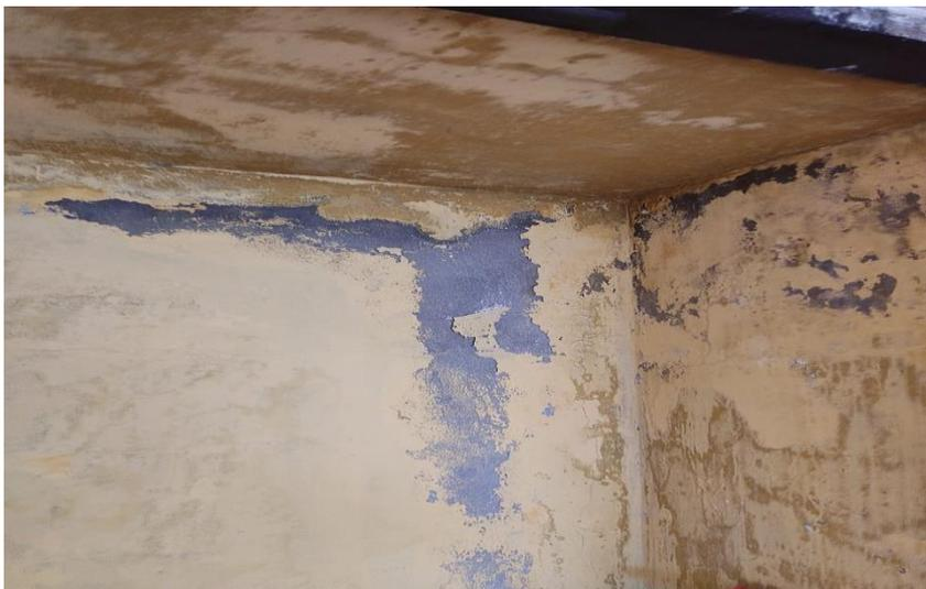
*Nota:* Humedad y Eflorescencia por deficientes instalaciones de agua y/o colapso de accesorios.
