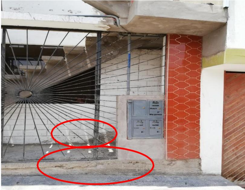
*Nota : Humedad proveniente del suelo y deficiente diseño de concreto(Eflorescencia secundaria)*
