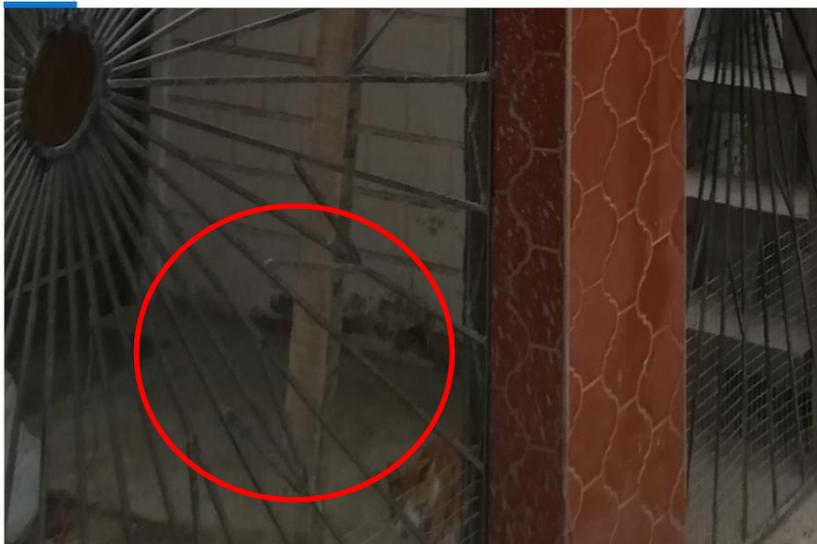
*Nota : Humedad proveniente del suelo, desprendimiento de revoque y pintura.*
