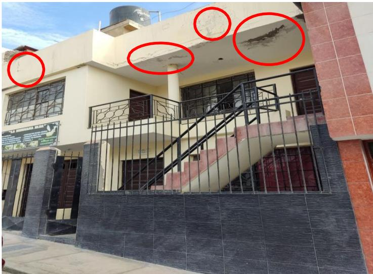
*Nota : Presencia de patología, Humedad por Lluvias o Apozamiento de Agua en Losa Ligera*
