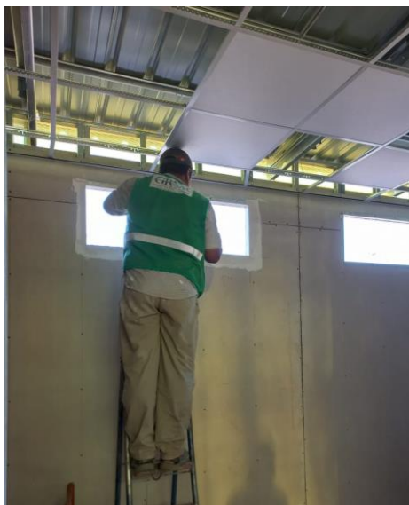
Colocación de falso cielo raso
