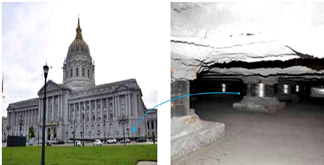
Figura 10. Aisladores Elastoméricos. San Francisco City Hall (EEUU)
