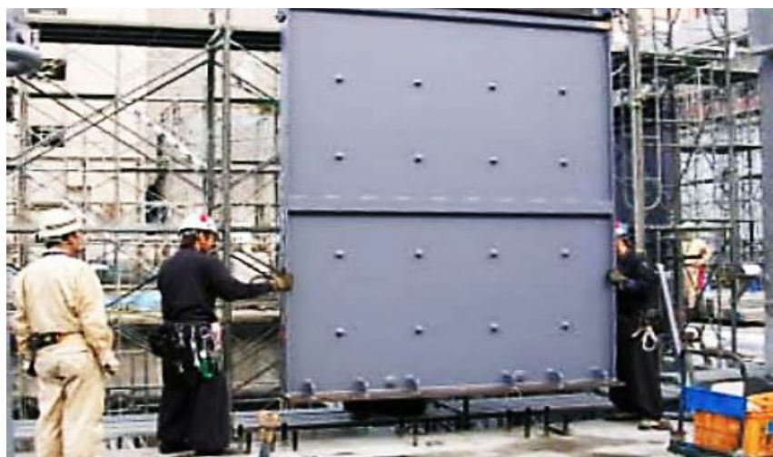
Figura 23. Colocación de un disipador muro viscoso
