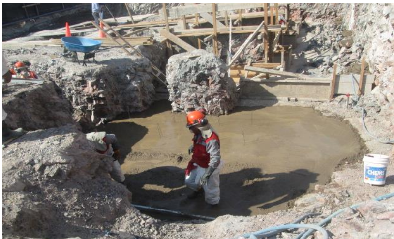
Concreto para solado
