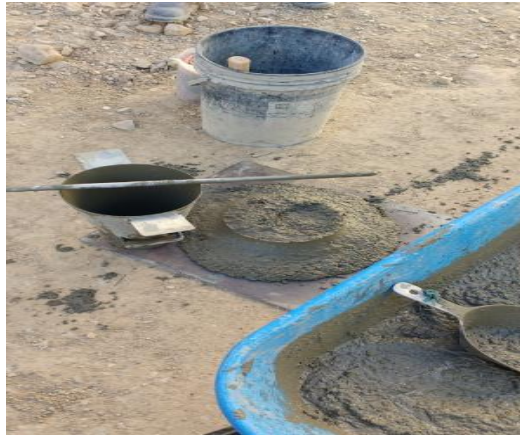
Figura 87. Ensayo de Slump en concreto con fibra. Fuente: Propia.
