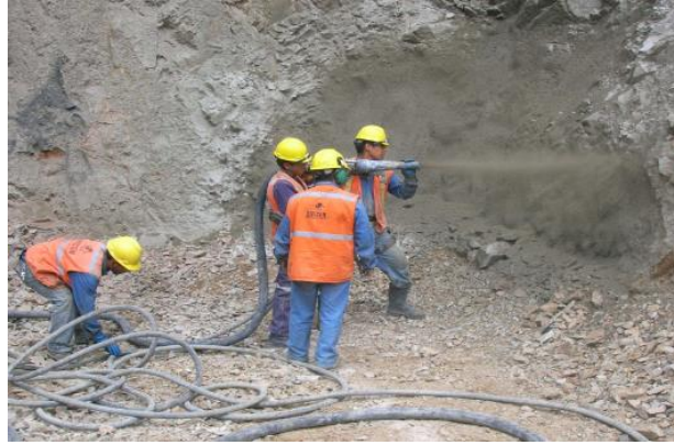
Figura 48. Aplicación de concreto lanzado en un talud. Fuente: Vercelli, 2009.
