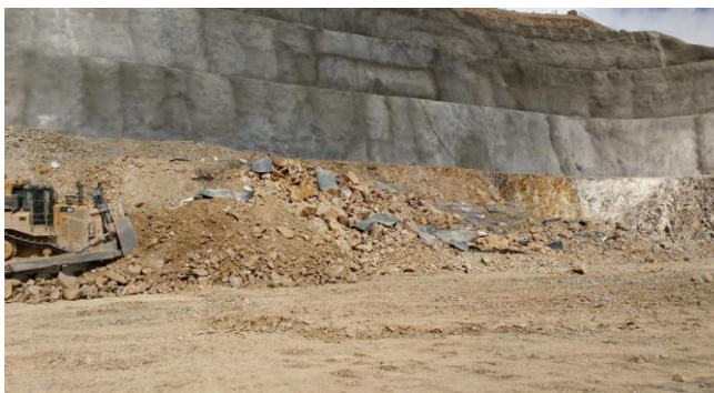
Figura 65. Roca dura en talud 1, se utilizó voladura. Fuente: Elaboración propia.
