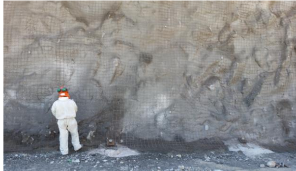
Figura 90. Colocación de malla electrosoldada. Fuente: Propia
