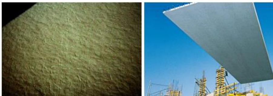
Figura 54. Tablero de puente fabricado con concreto reforzado con fibras de acero. Fuente: López, 2015.
