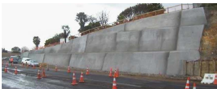
Figura 47. Recubrimiento con concreto lanzado. Fuente: Suárez, 2006.
