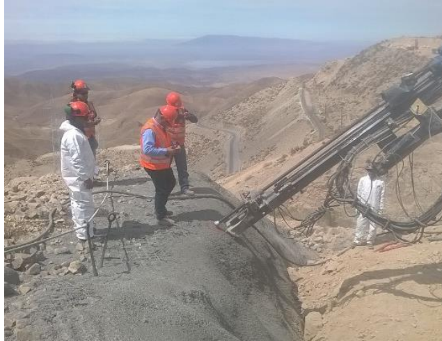
Figura 89. Colocación de los pernos autoperforantes Fuente: Propia
