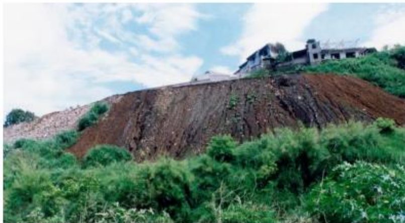
Figura 2. Deslizamiento producido por la saturación del Suelo, se puede observar la inclinación de los arboles respecto de la vertical, lo que hace pensar que esta ante la presencia de creep. Fuente: Matteis, 2003.
