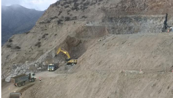
Figura 67. Material rocoso en el talud norte Fuente: Elaboración propio
