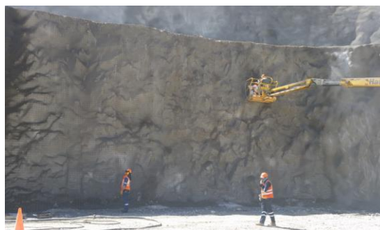
Figura 91. Colocación de malla electrosoldada con equipo elevador. Fuente: Propia
