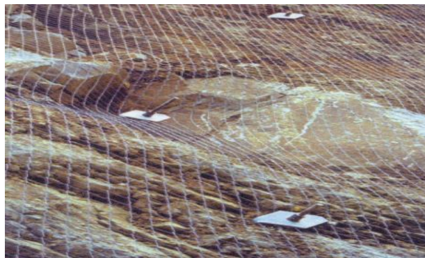
Figura 44. Anclaje de las mallas Fuente: Suárez, 2006
