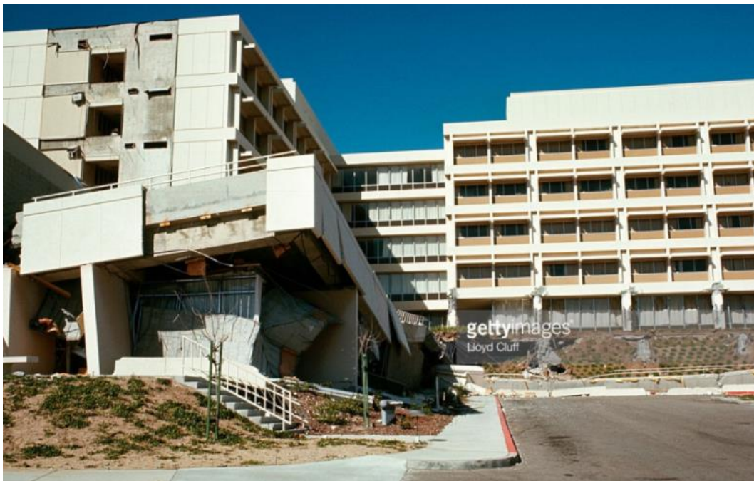
Figura 1. Colapso del hospital Olive View después del terremoto
