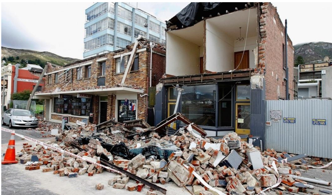
Figura 12. Daños en estructura de albañilería después del terremoto de Kaikoura
