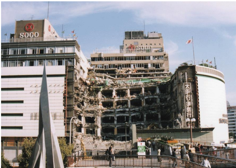
Figura 4. Colapso de edificios de concreto armado, Kobe de 1995
