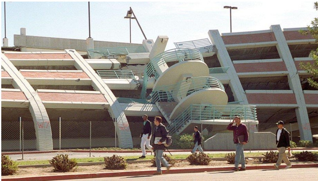
Figura 3. Cal State Northridge, después del terremoto de Northridge 1994
