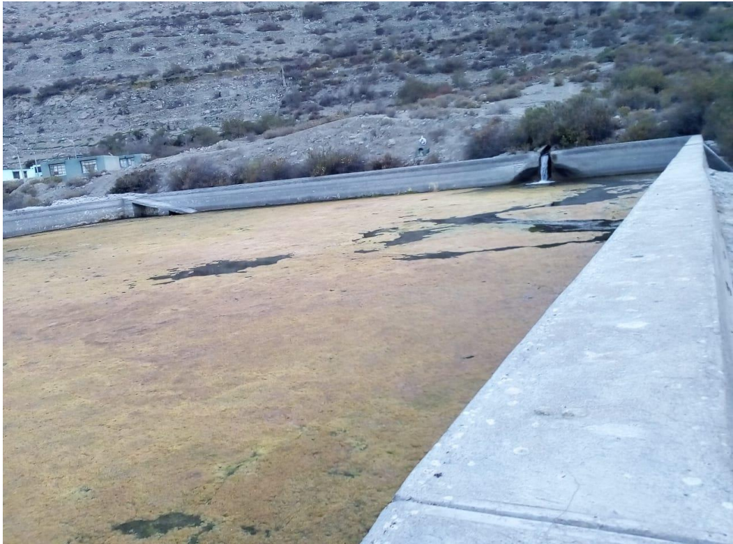
Figura 5. Vista panorámica del reservorio Chacalaquita
