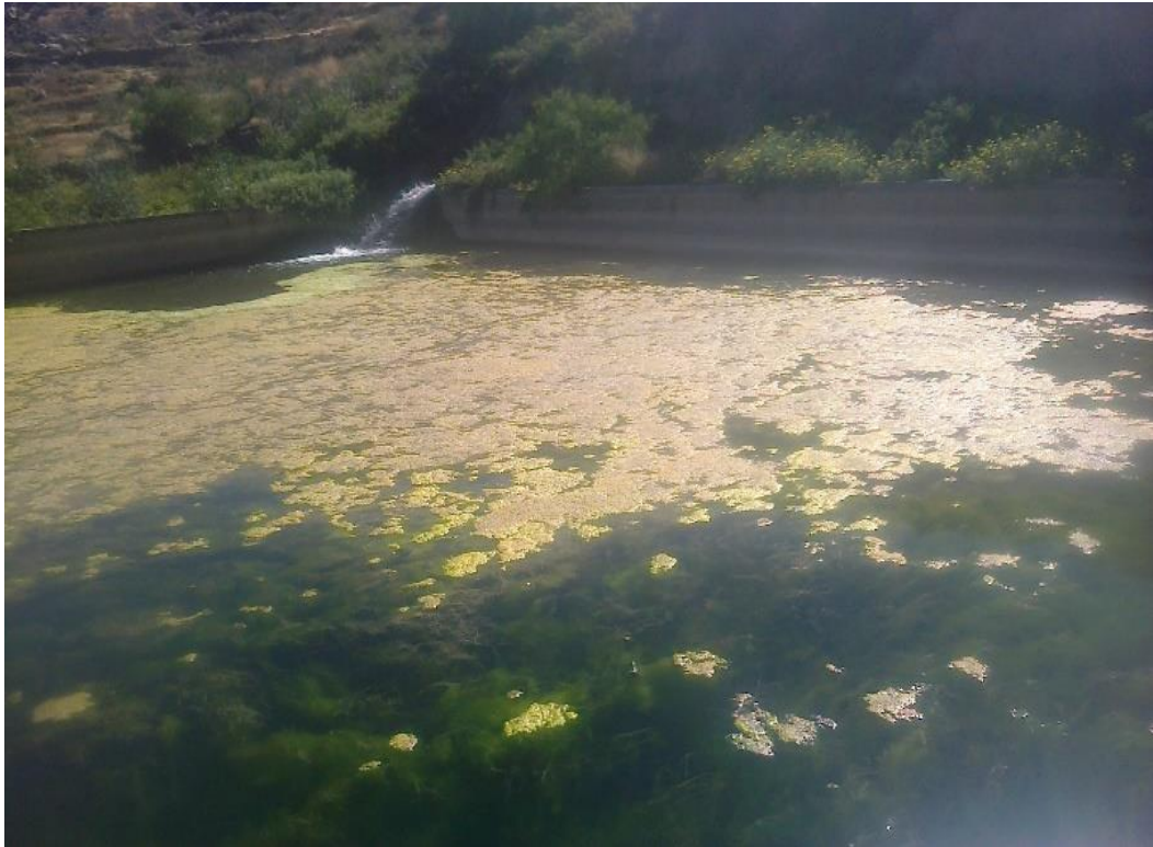
Figura 2. Vista panorámica del reservorio Ventana 01
